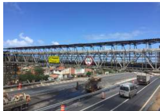
Passarela provisória para pedestres sobre a Rodovia BA-093
