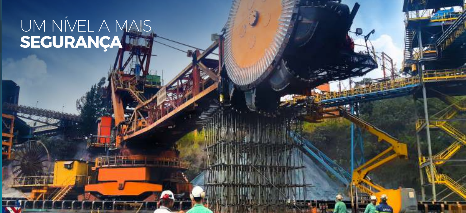
Retomadora de 90 toneladas apoiada sobre escoramento na mina de Brucutu - MG
